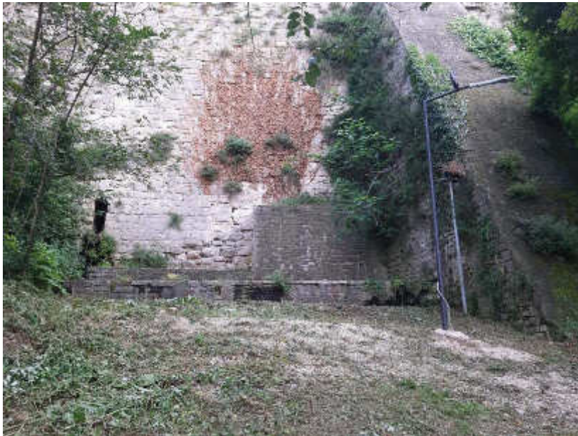
Foto 2.6 – Vista post operam
