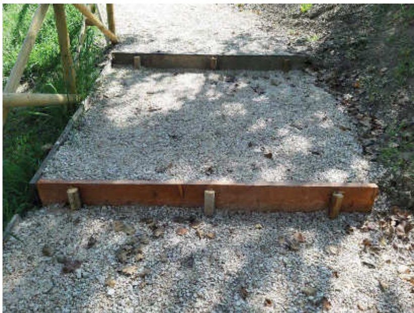
Foto 1.9 – Vista post operam
