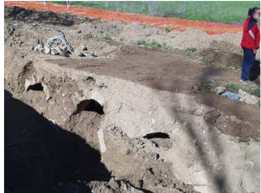
Foto 6.4 – Vista in corso d'opera
