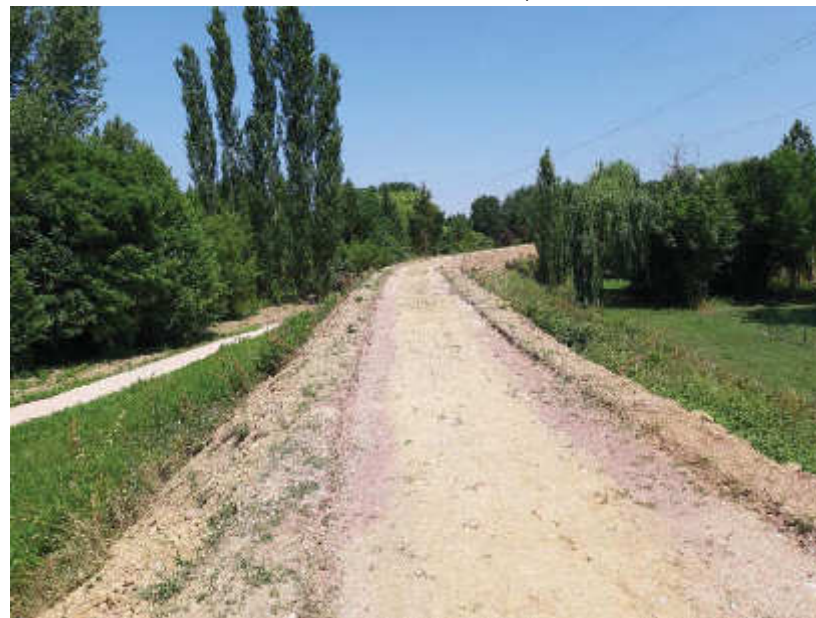
Foto 7.2.4 – Vista in corso d'opera
