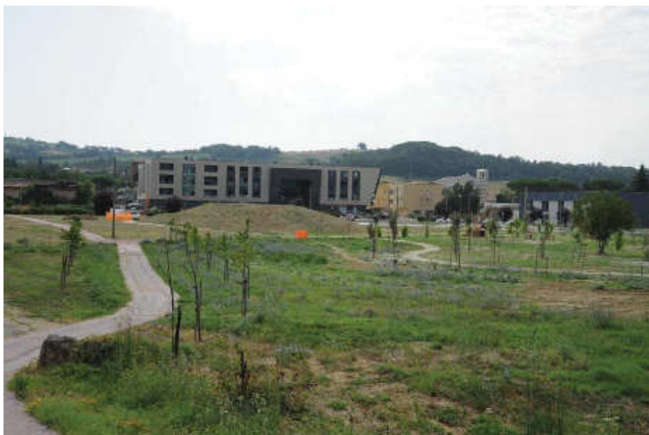
Foto 7.3.14 – Vista post operam
