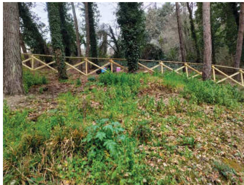
Foto 1.7 – Vista in corso d'opera
