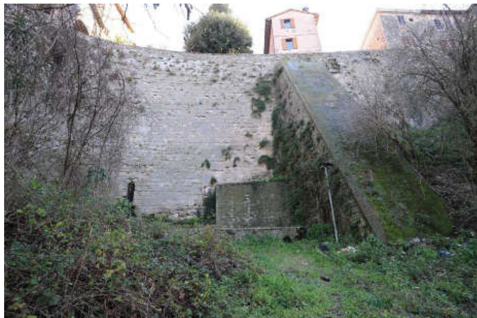
Foto 2.1 – Vista ante operam
