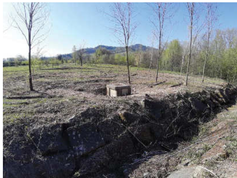
Foto 7.1.3 – Vista in corso d'opera
