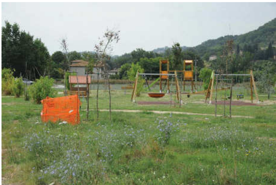
Foto 7.3.13 – Vista post operam
