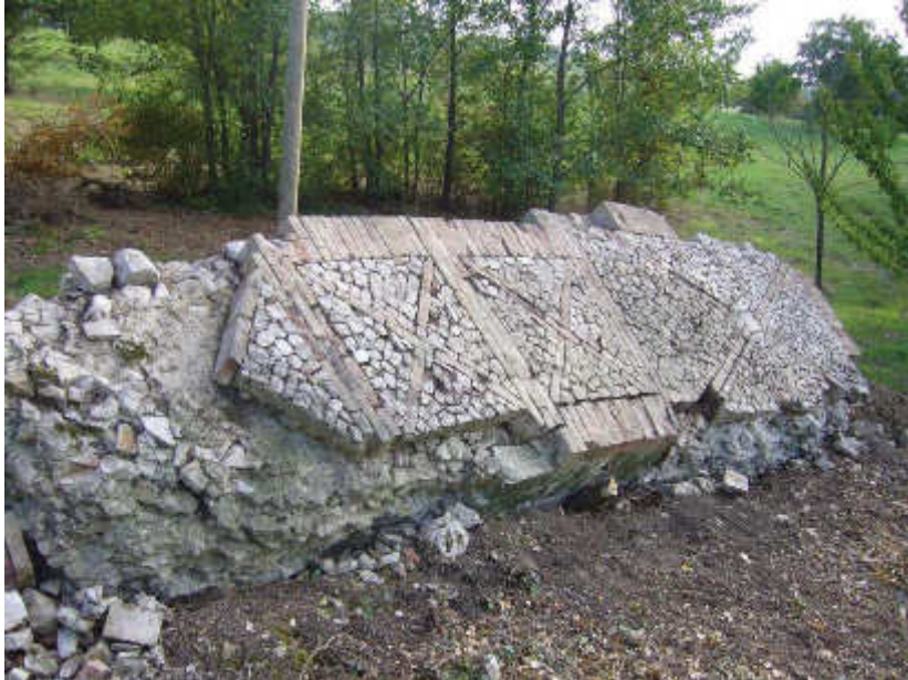
Foto 4.1 – Vista ante operam
