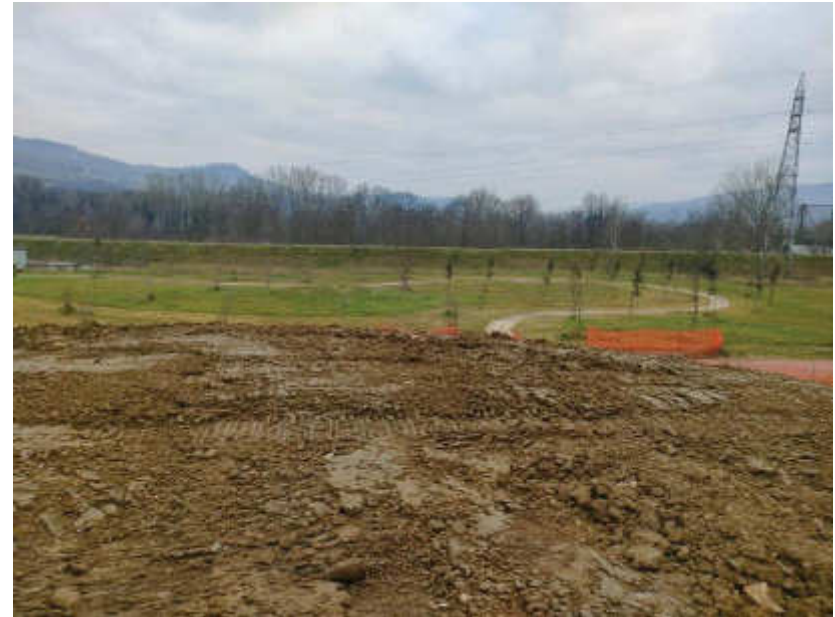
Foto 7.3.7 – Vista in corso d’opera
