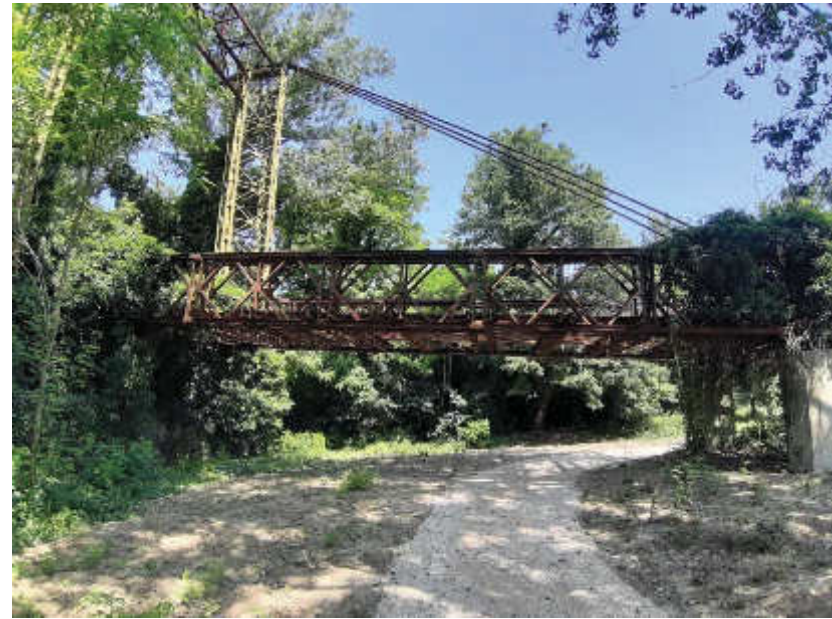
Foto 7.1.6 – Vista post operam
