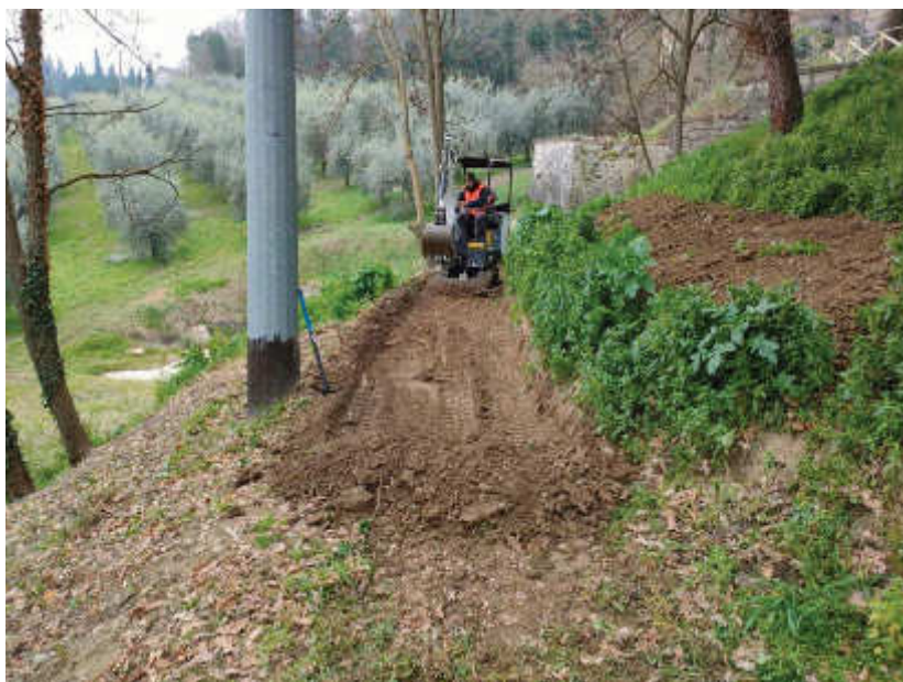
Foto 1.6 – Vista in corso d'opera
