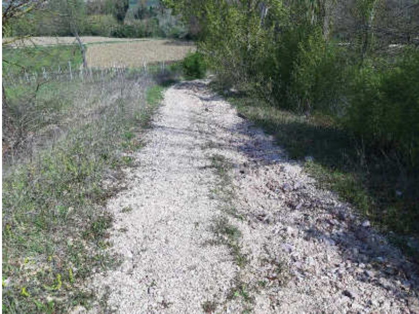
Foto 3.1 – Vista ante operam
