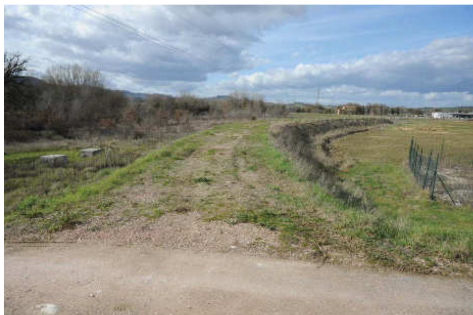
Foto 7.1.2 – Vista ante operam
