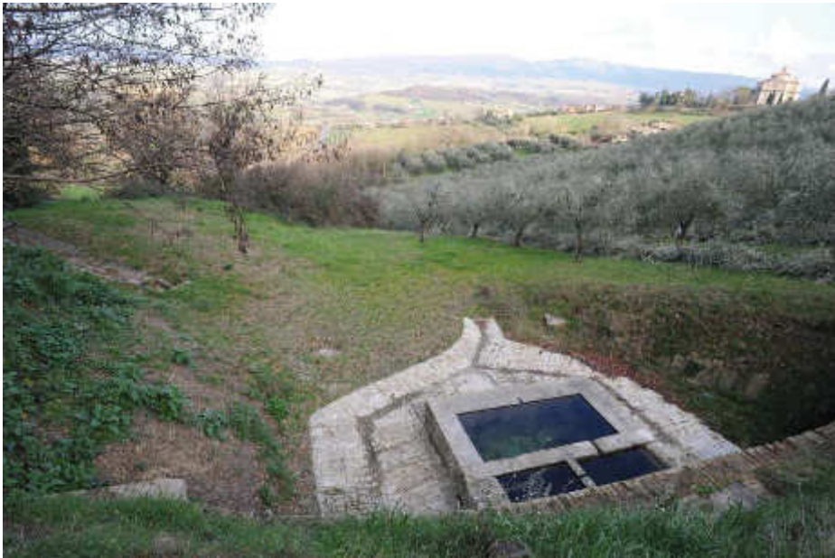
Foto 1.2 – Vista ante operam
