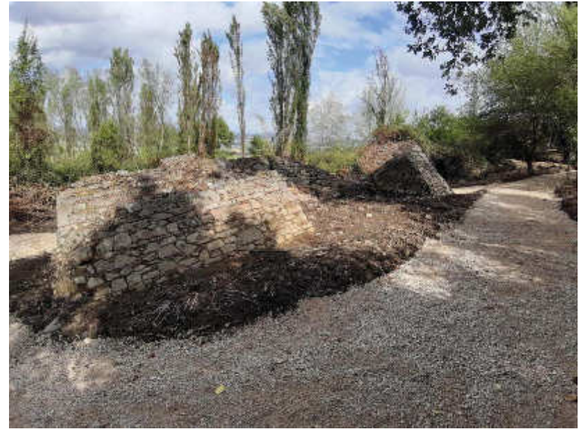
Foto 4.7 – Foto 4.6 – Vista post operam
