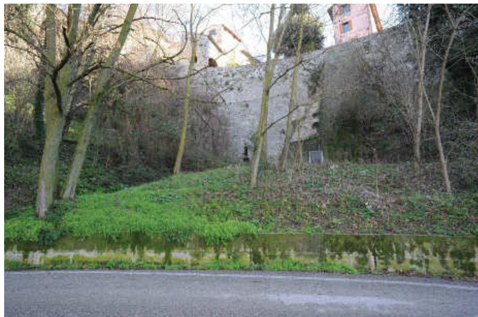
Foto 2.2 – Vista ante operam
