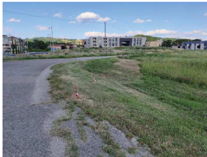
Foto 7.3.3 – Vista in corso d'opera
