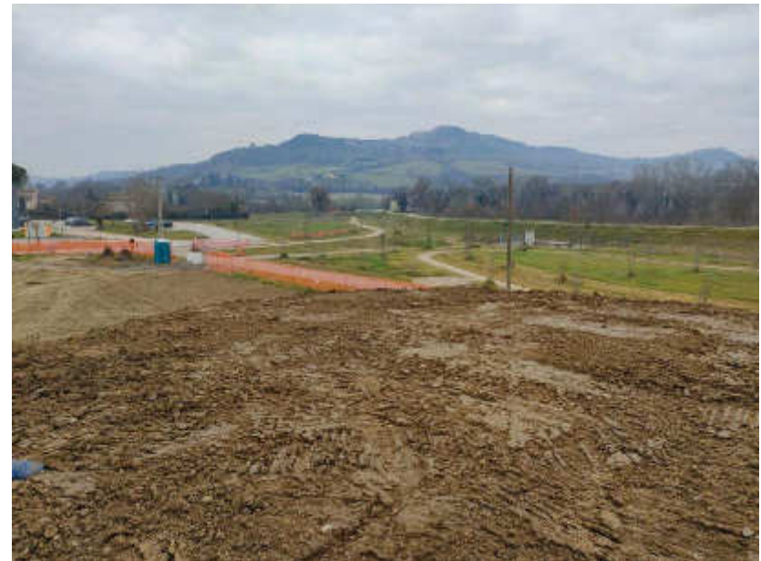
Foto 7.3.8 – Vista in corso d’opera
