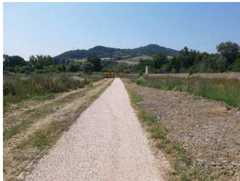
Foto 7.3.4 – Vista in corso d'opera
