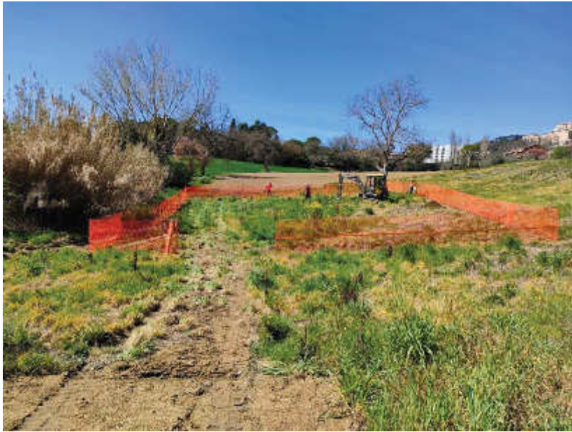
Foto 6.5 – Vista in corso d'opera
