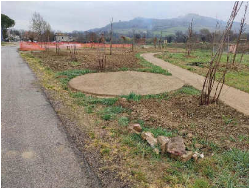
Foto 7.3.5 – Vista in corso d’opera
