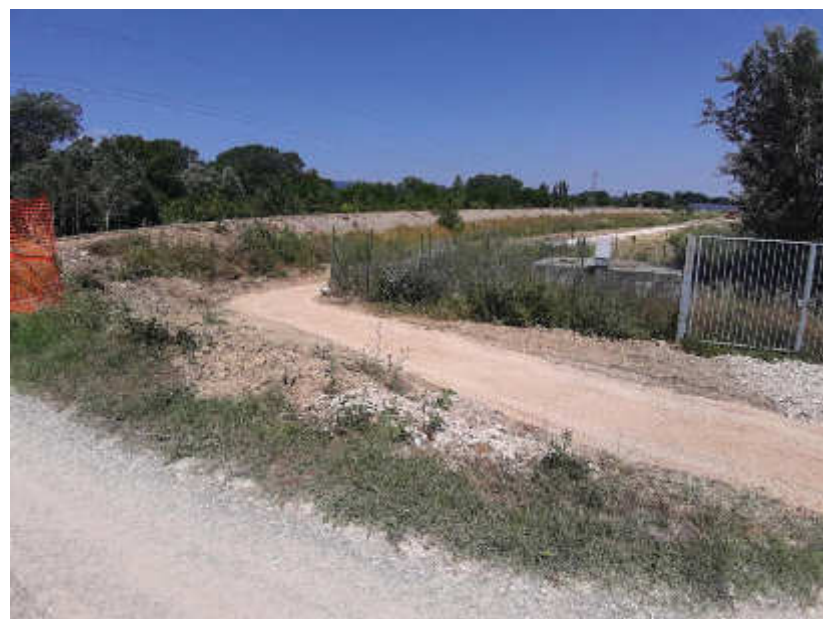
Foto 7.1.4 – Vista in corso d'opera
