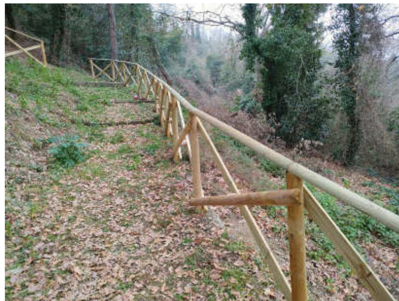
Foto 1.11 – Vista post operam
