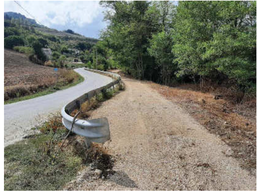
Foto 3.10 – Vista post operam
