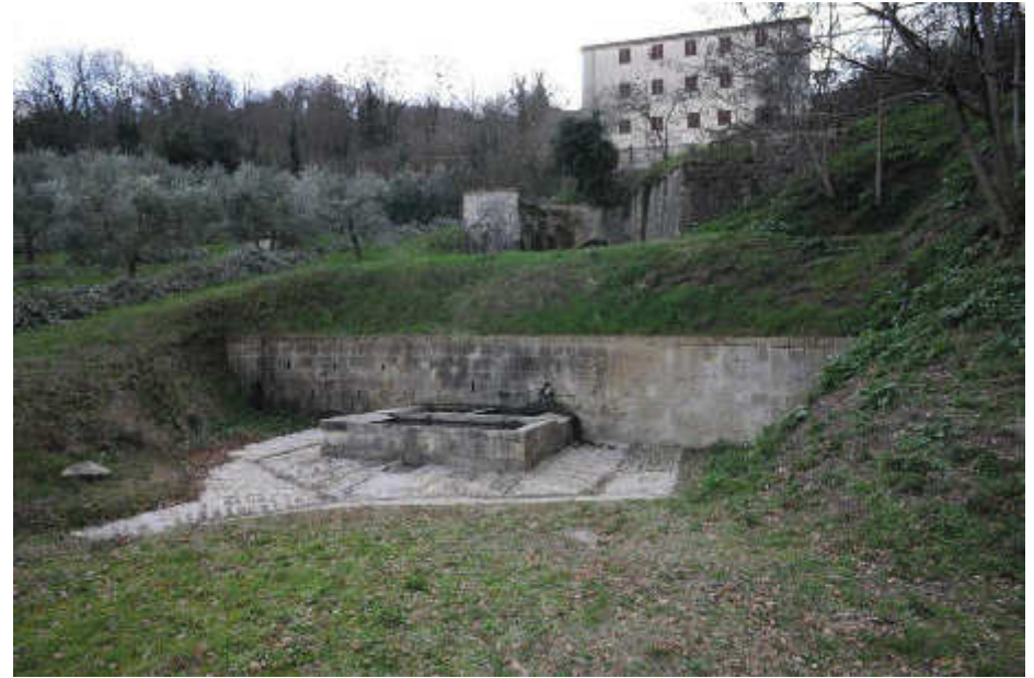
Foto 1.3 – Vista ante operam
