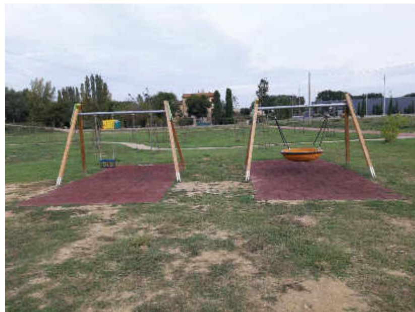
Foto 7.3.11 – Vista post operam
