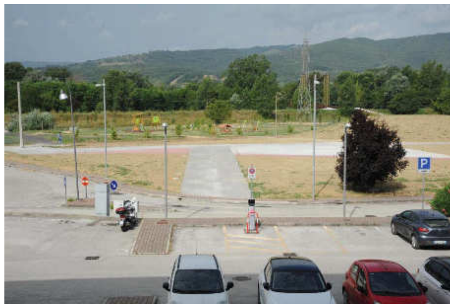
Foto 7.3.12 – Vista post operam
