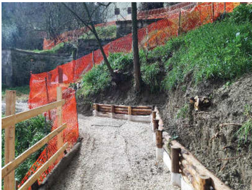
Foto 1.5 – Vista in corso d'opera
