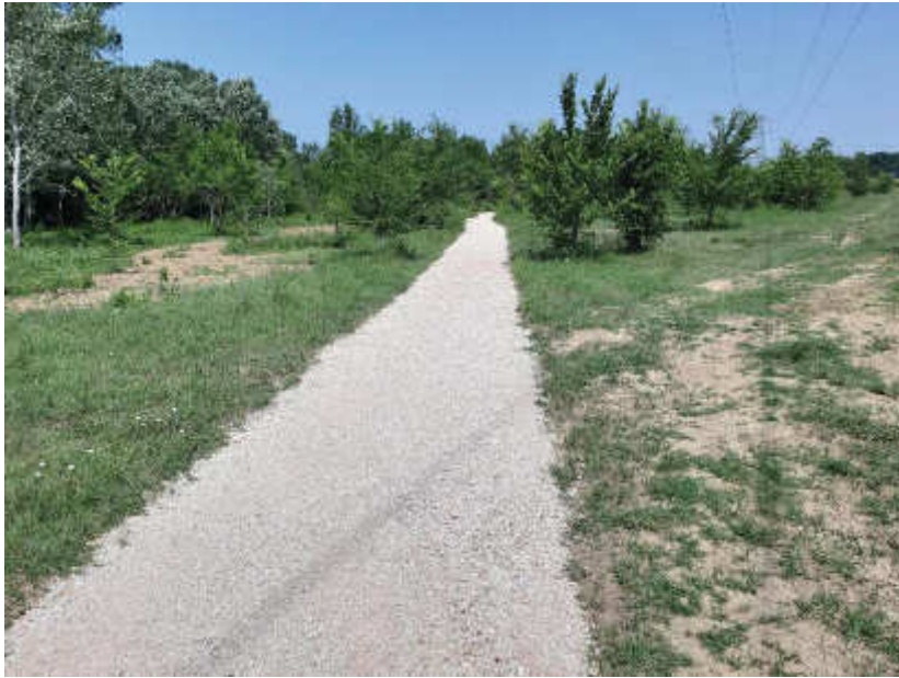
Foto 7.2.5 – Vista post operam
