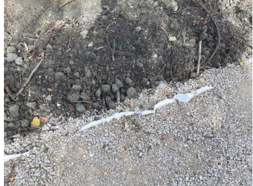
Foto 4.3 – Vista in corso d'opera
