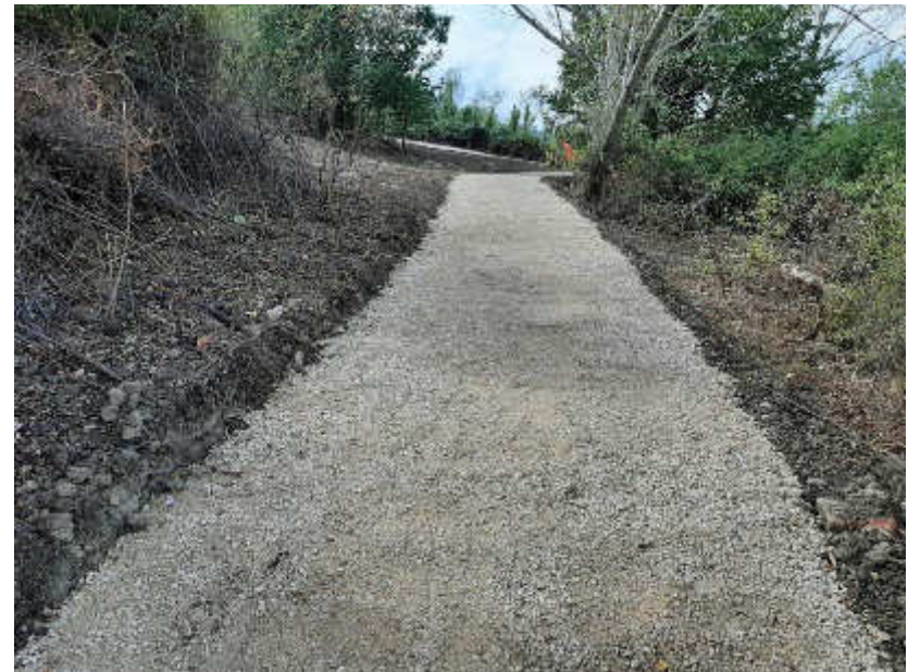
Foto 4.4 – Vista in corso d'opera
