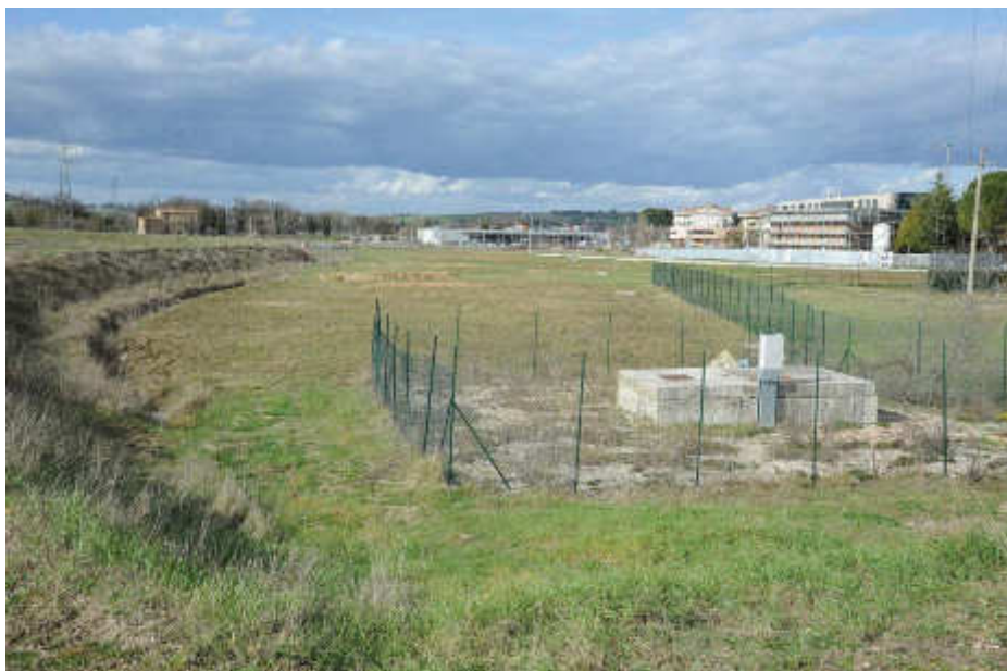
Foto 7.3.2 – Vista ante operam
