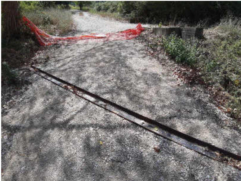
Foto 3.6 – Vista in corso d'opera
