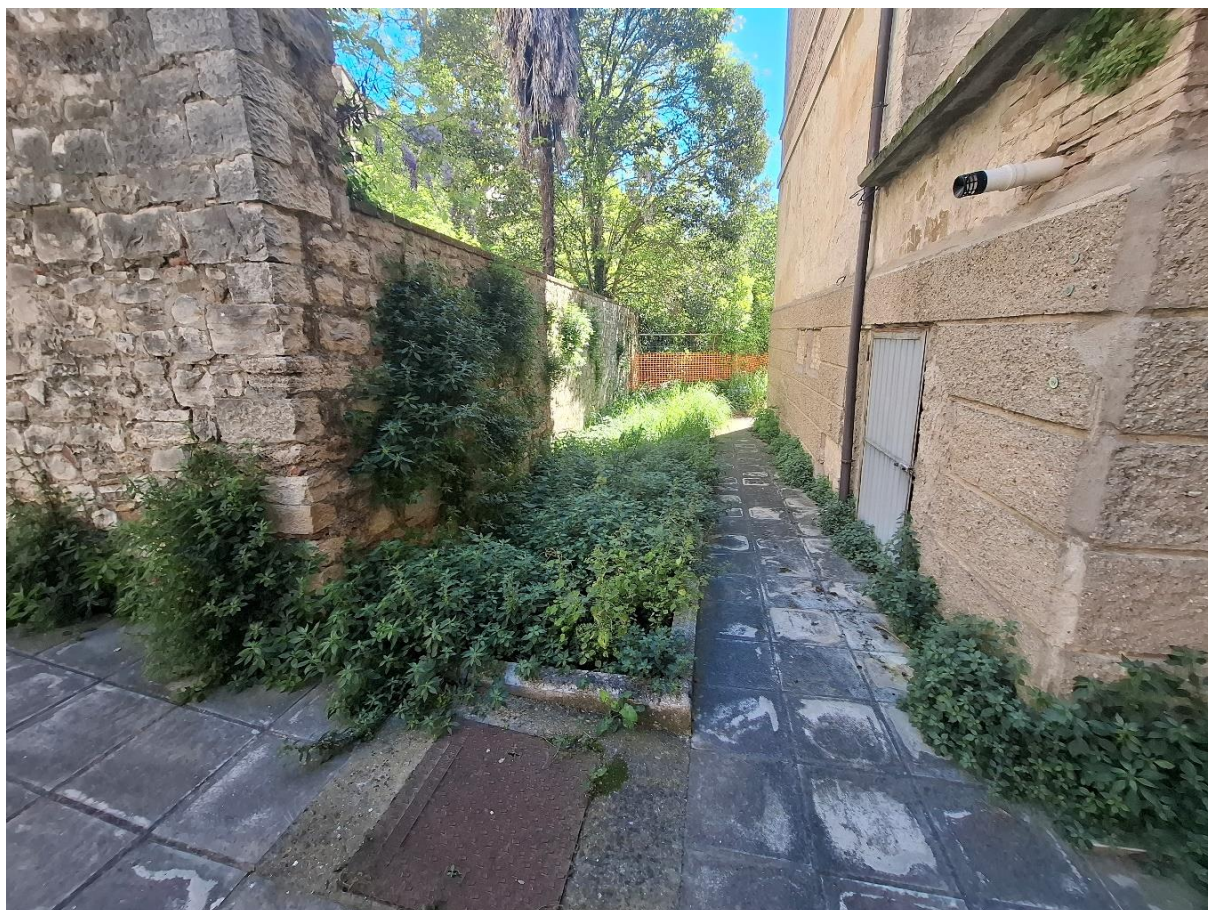
FOTO 2 - Vista del percorso esterno al piano terra che porta al giardino pensile
