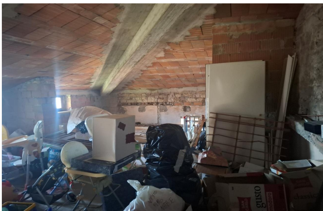
FOTO 22 - Vista del sottotetto
