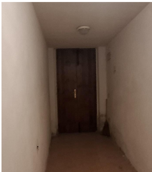
FOTO 11 - Vista della porta di uscita al giardino pensile
