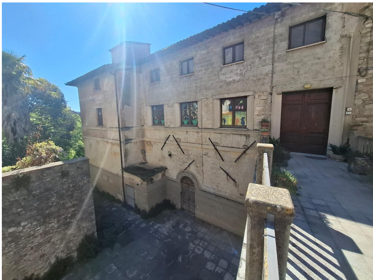
FOTO 1 - Vista della facciata su via Santa Maria in Cammuccia
