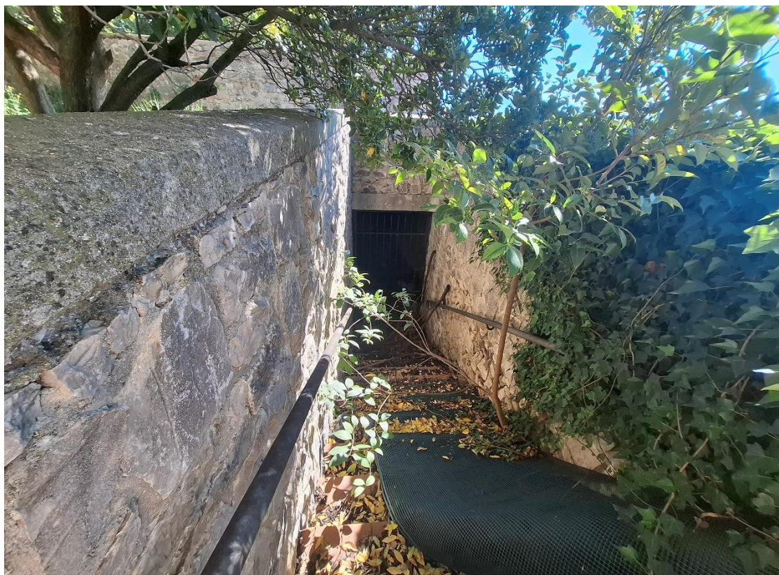
Foto 4 - Vista della scala del giardino dall'alto
