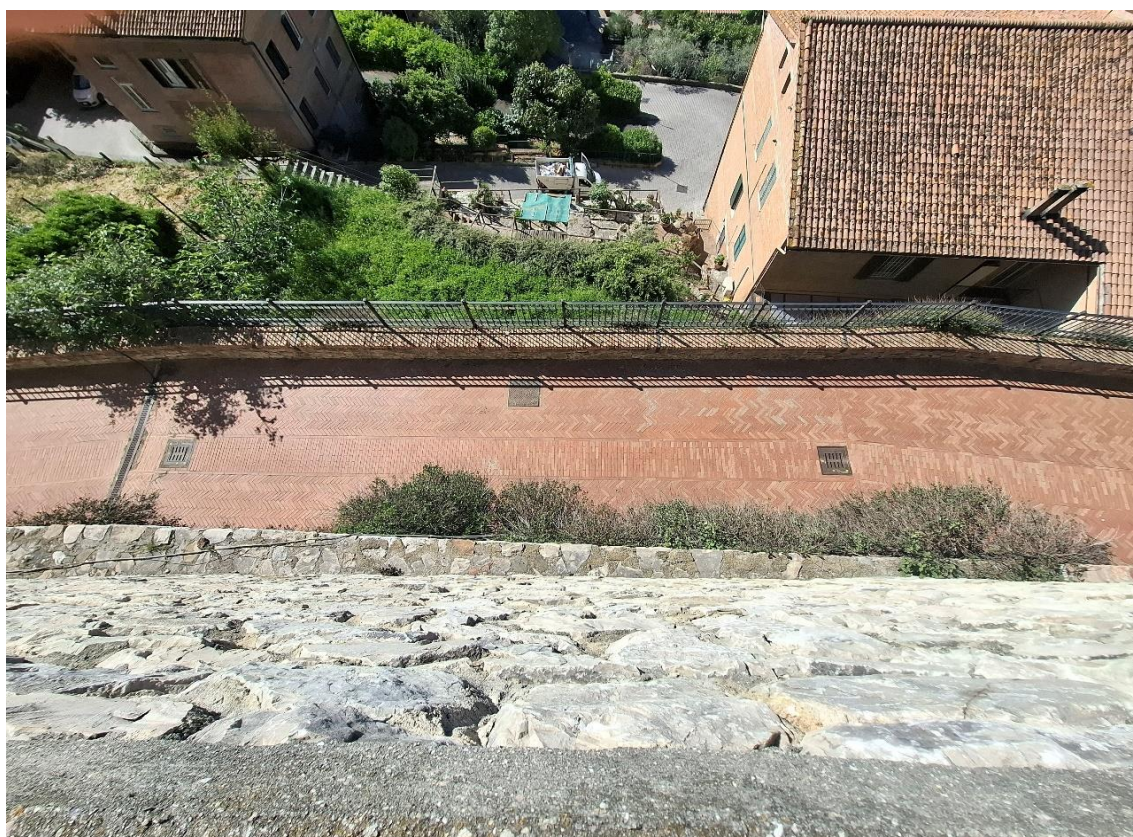
FOTO 5 - Vista della Via di Mezzo muro dal parapetto del giardino pensile
