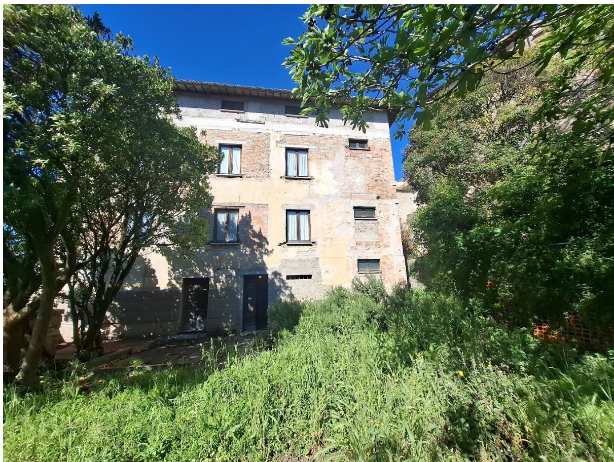
FOTO 3 - Vista della facciata laterale che guarda il giardino pensile
