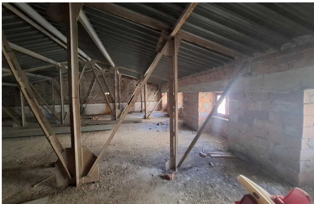
FOTO 21 - Vista del sottotetto
