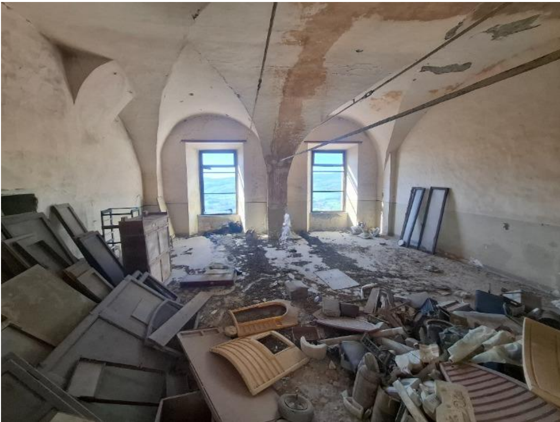
FOTO 8 - Vista della sala grande al piano terra, in direzione dei finestrone esterni
